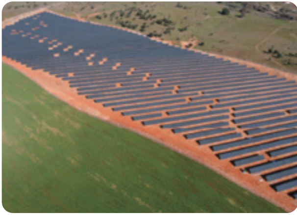
Planta Solar de Salamanca, Spain
